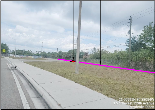
STA 13+40 INSTALL PEMBROKE PINES HANDHOLE
