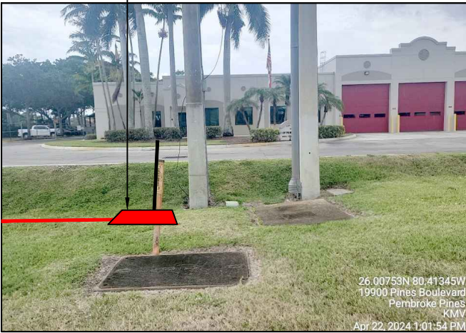
STA 0+90 INSTALL PEMBROKE PINES HANDHOLE
